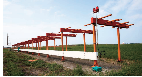
▲（左）桃園機場23R跑道的左右定位臺天線群。（右）桃園機場05R跑道右側的滑降臺天線。
