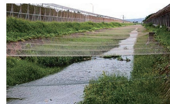
▲（上）桃園機場公司裝置在滑行道旁標示牌上方的防鳥刺，讓鳥類無法停留。（下）桃園機場南側環場道旁排水溝上方裝設的紗網，讓鳥類無法至排水溝喝水、覓食。
