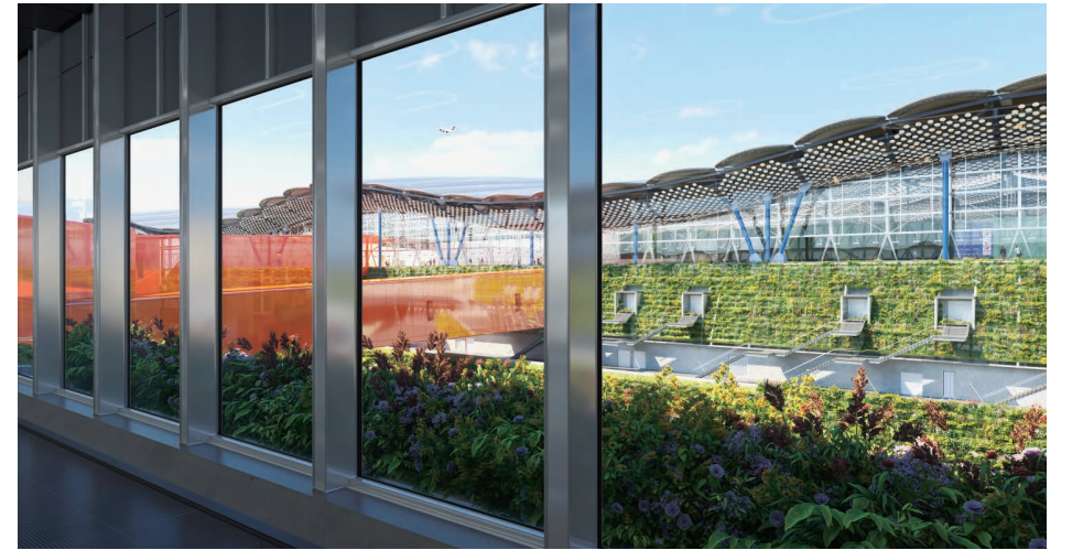
▲通透的外牆，讓室內外景觀接續，空間感受更加自由無拘束、室外造景也為室內增加自然的氣息。
