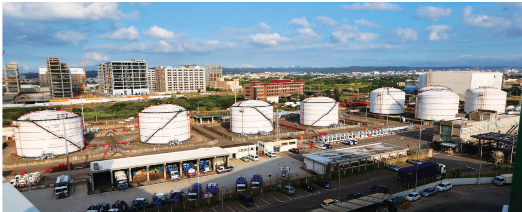
▲桃園國際機場公司航務處航油科設在貨運園區入口處附近的8座儲油槽，右側4座每座容量8,000公秉，左側4座容量6,000公秉。
