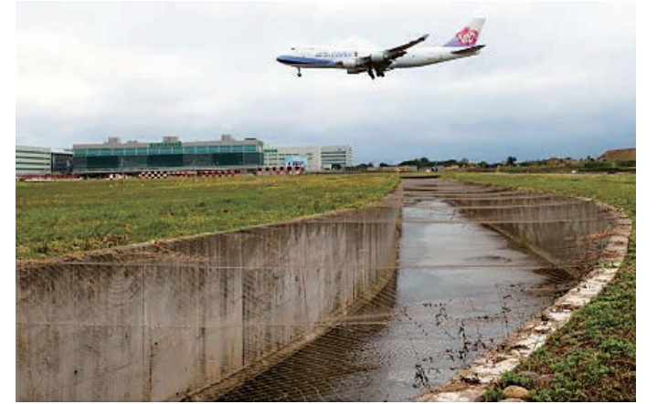
▲（左）桃園機場05L跑道頭架設的垂直鳥網，防止鳥類進入跑道操作區。（右）桃園機場05L跑道頭排水明溝上方裝設的紗網，阻隔航機起降頻繁區域的鳥類活動。
