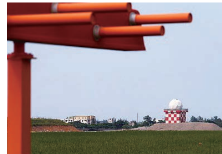
▲裝設在桃園機場05L跑道北側的都卜勒氣象雷達，左上角為23R跑道左右定位臺天線。
