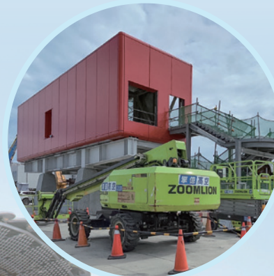
◀ 正在進行的北登機廊廳空橋安裝作業。 Ongoing installation of airbridges at the North Concourse.
