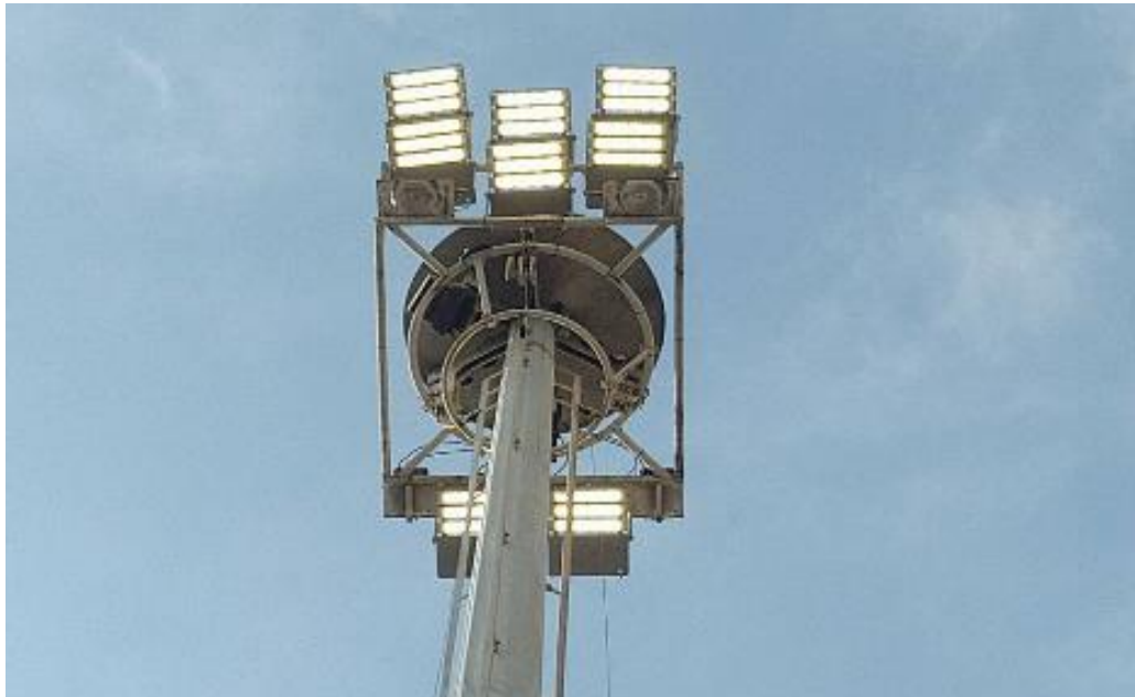
▲ 第一、二航廈照明及設備改善工程(機坪投光燈汰換)
