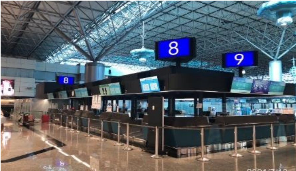
▲第二航廈報到櫃台行李設備汰換工程（第8、9號及第16、17號櫃台）
