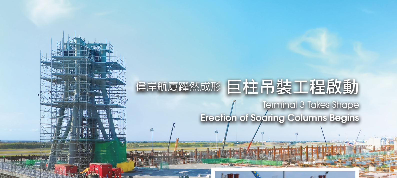
▲ 桃園國際機場第三航廈正在進行巨柱吊裝工程。 TTIA Terminal 3 undergoing column erection works.
